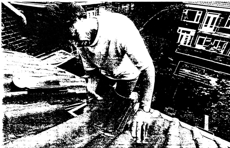
• A. Ooms brengt een speciale dakpan aan, waarin door gierzwaluwen of mussen genesteld kan worden.
